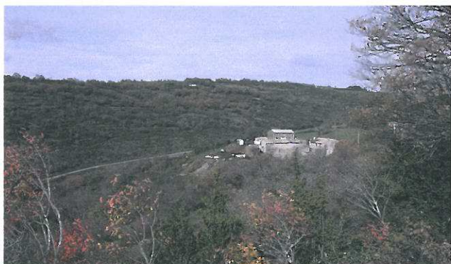
Vers le nord ouest: Séveyrac: paysage agricole et de lande
