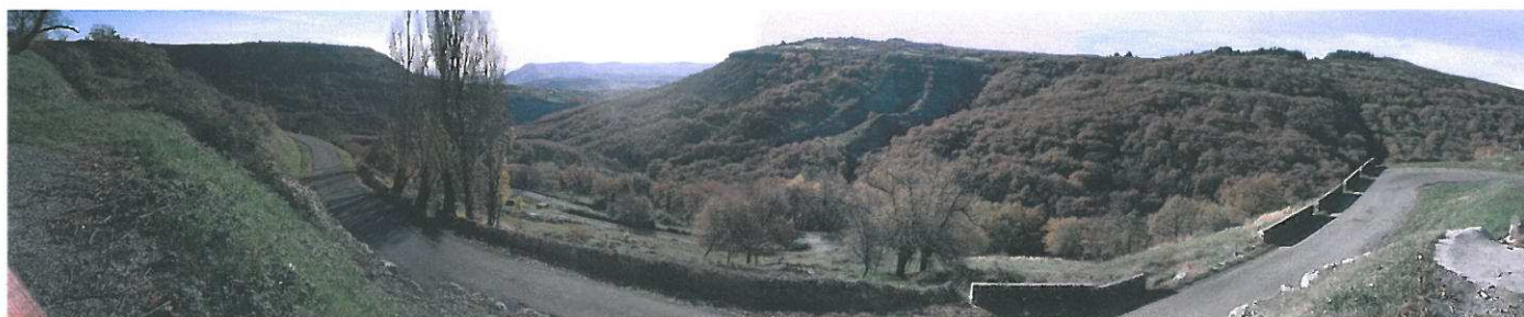
Vallée de la Claduègne vue vers le sud depuis Monteillet
