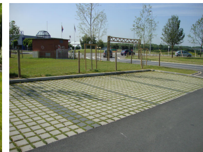
pavage béton enherbé
