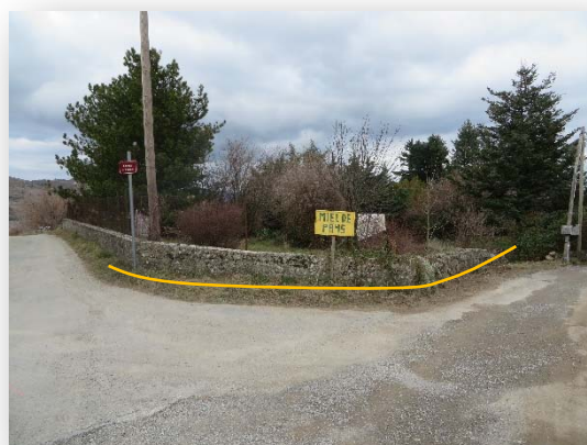
Muret en pierre sécurisant le carrefour et prolongé au nord par un mur en béton
