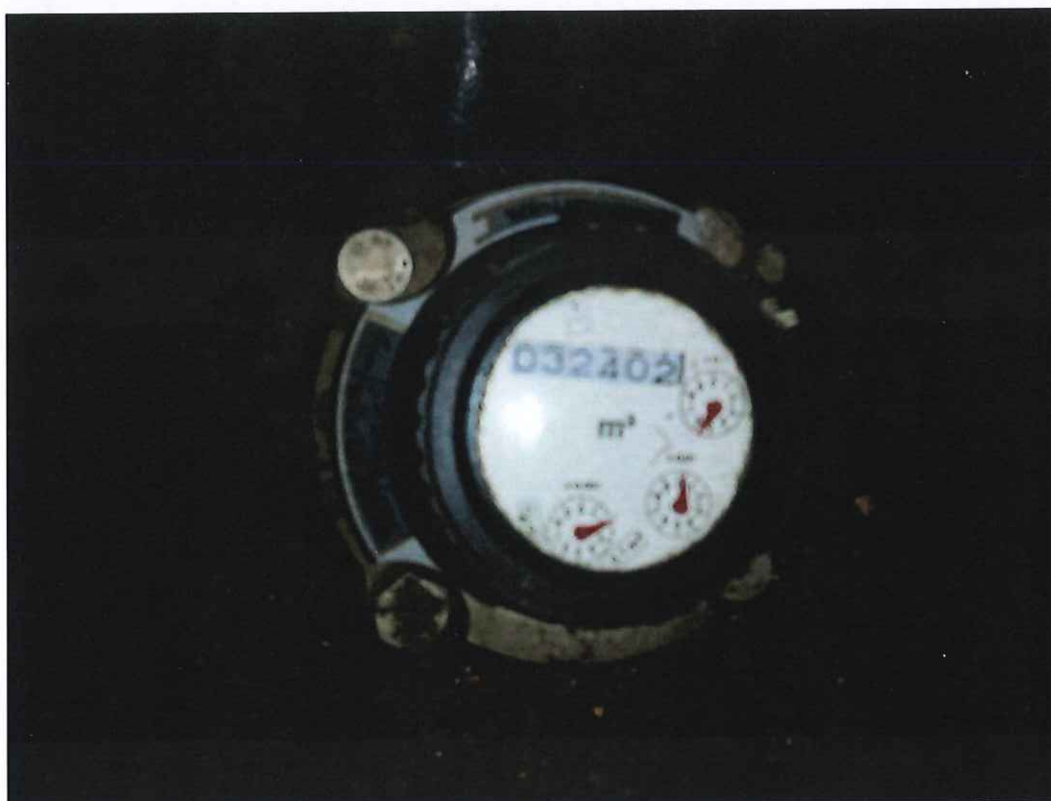
Photo du Compteur C4 – Distribution d'eau à partir du réservoir de La Grange vers le hameau La Grange
