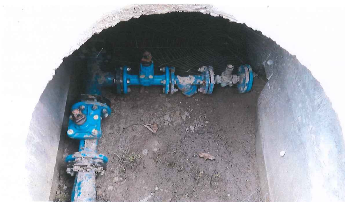
Photo du réducteur de Pression RP17 – Blachon
