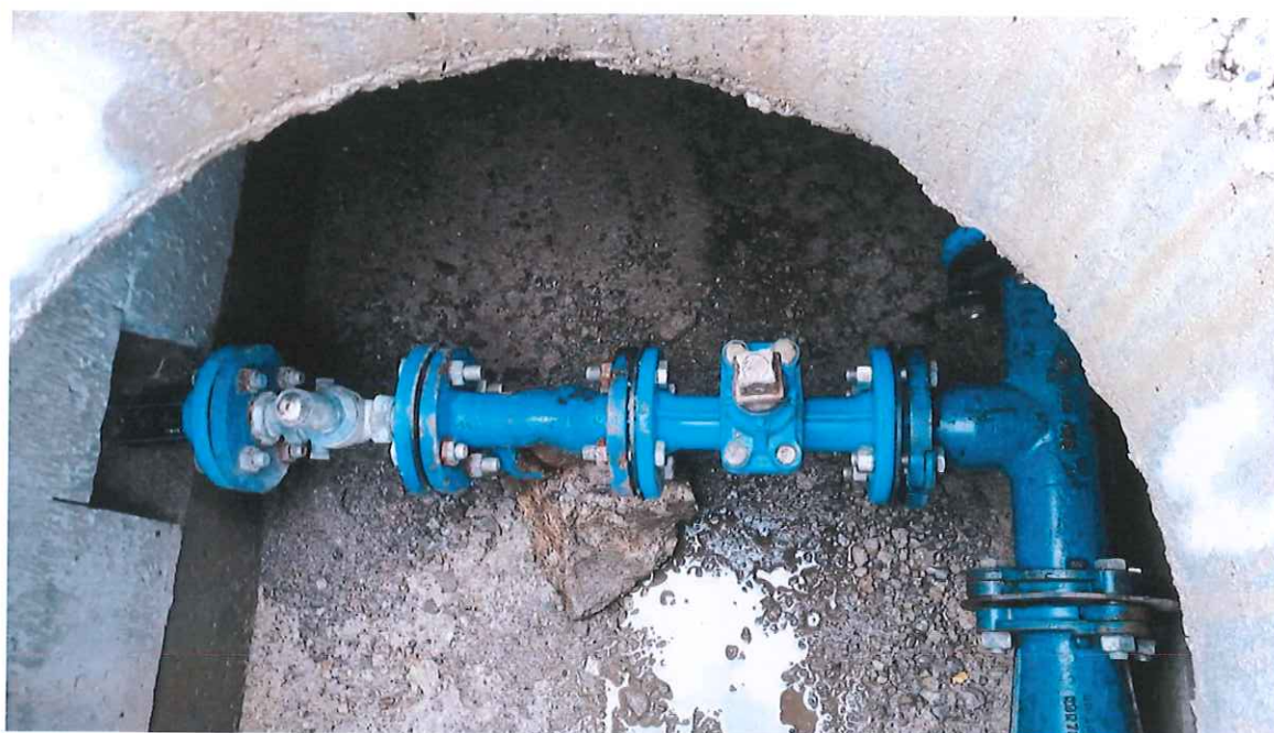
Photo du réducteur de Pression RP20 – La Crouzat
