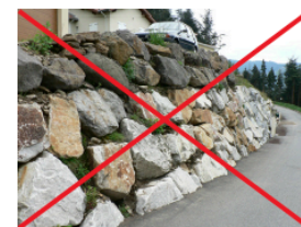
Exemple d'enrochements de type cyclopéen
