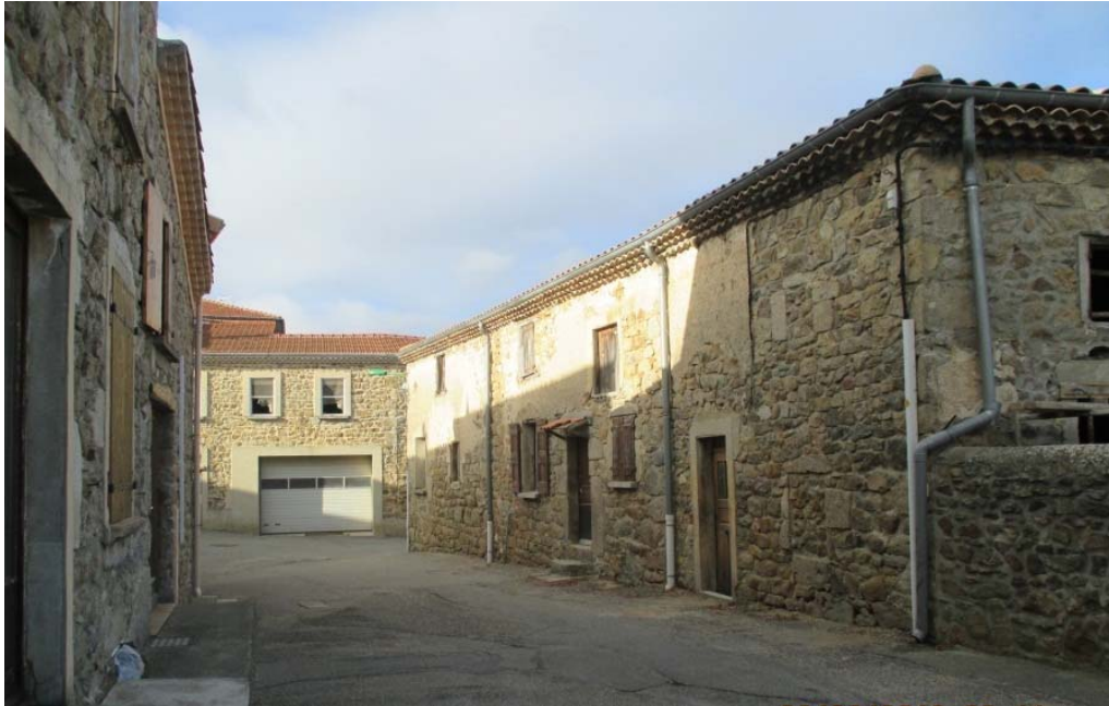
Rue de l'église constituée d'habitations en pierres dans le bourg ancien
