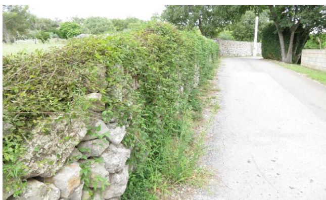
Muret situé en bordure sud de la parcelle 349 située au lieu-dit Chadouiller
