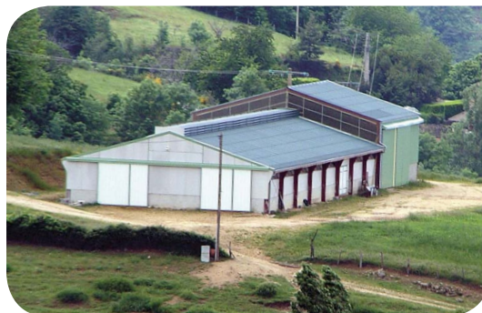
Bâtiment agricole actuel, bâtisse peu adapté à son environnement : - trop de terrassements ; - abords non aménagés ; - matériaux disparates.
