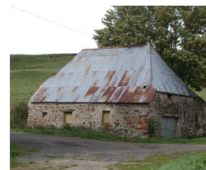
Pierre et tôle ondulée en couverture.
