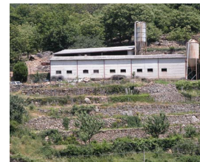
Préfabriqué béton et amiante ciment.
