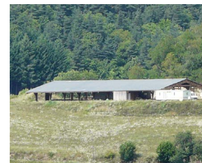
Charpente lamellé.collé et bac acier.
