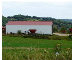
Bac acier en mur et couverture.
