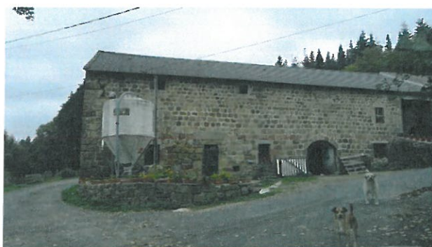
Etable (partie sud) – Façade Est
