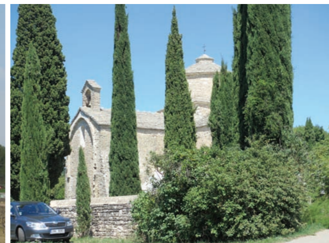
Cyprès ponctuant les abords de l'église Saint-Pierre de Larnas
