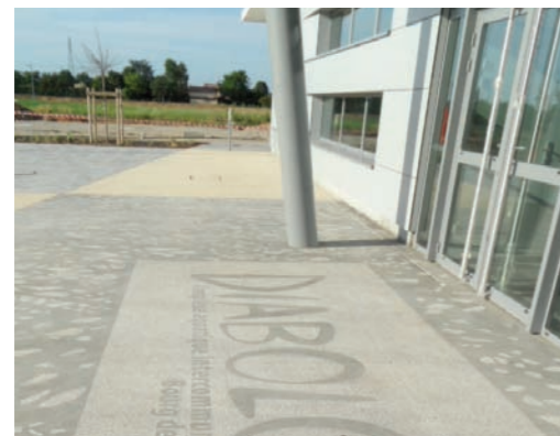
Traitement du seuil d'entrée d'un équipement avec inscription au pochoir du logo de l'équipement
