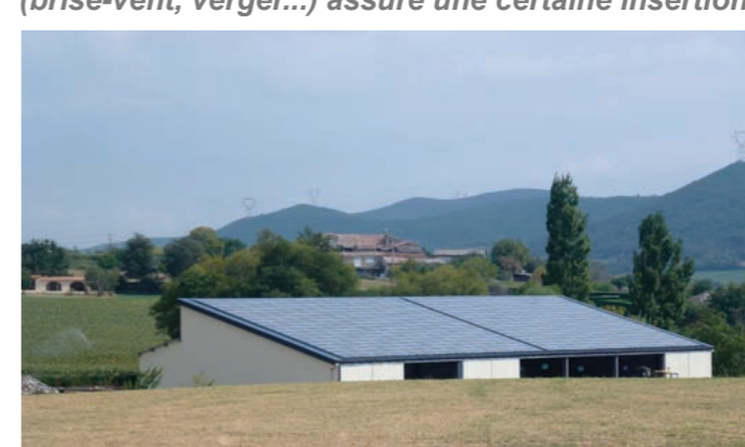
Teintes de façades trop claires, façades et toitures trop tranchées
