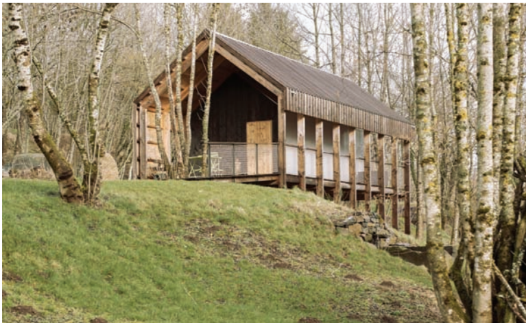
'Le bois basalte', hameau d'hébergement composé d'un groupe de gîtes s'apparentant à des cabanes dans les bois - Commune de Manzat (Dépt : Puy-de-Dôme) Respect de la topographie naturelle, Volumes simples, archétypaux et unitaires associant les différentes fonctions : habitation, loggia, balcon...
