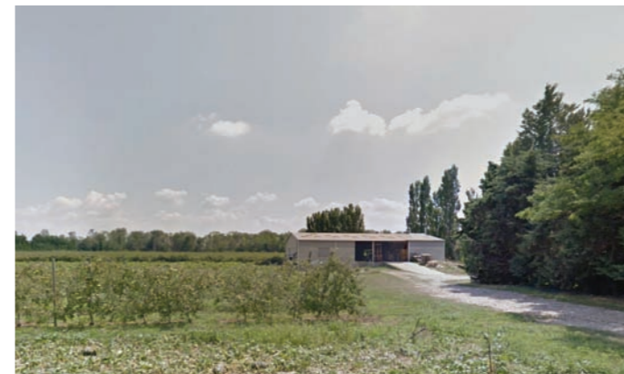
St-Just-d'Ardèche - Façades peu valorisantes (moellons non revêtus) mais la trame végétale (brise-vent, verger...) assure une certaine insertion
