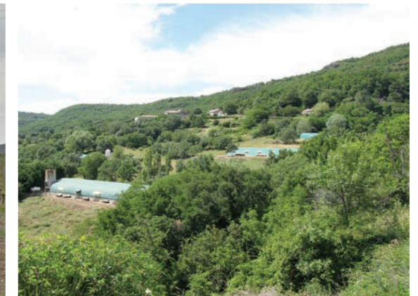
Saint-Pierre-la-Roche - La teinte des tunnels ne s'adapte pas au site
