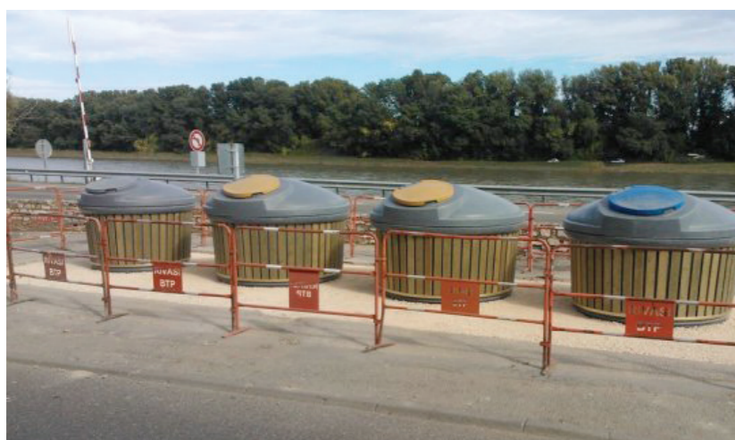
Bourg-Saint-Andéol : Conteneurs semi-enterrés en cours d'installation sur les quais du Rhône / Source : http://www.bsa-ville.fr
