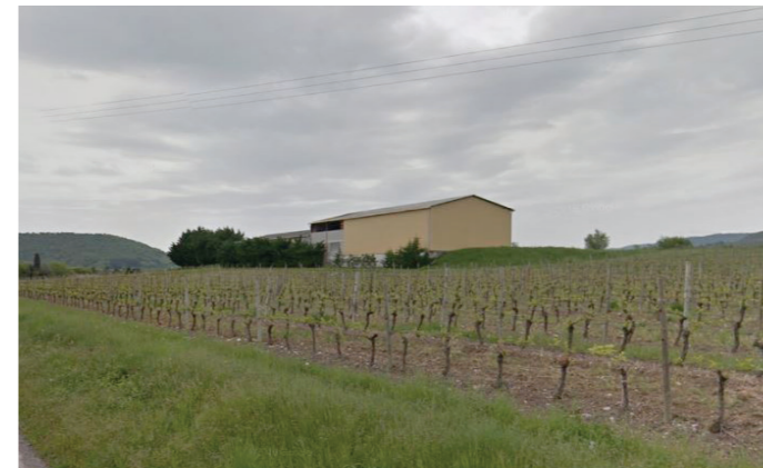
Alba-la-Romaine - Bâtiment très volumineux perché sur son remblai, matériaux disparates.
