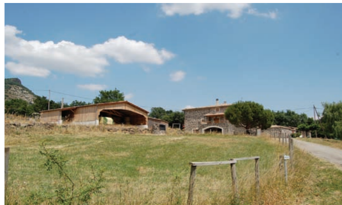
Saint-Martin-sous-Lavezon - Bonne échelle du bâtiment agricole vis-à-vis de l'habitation, bonne intégration du bardage bois.
