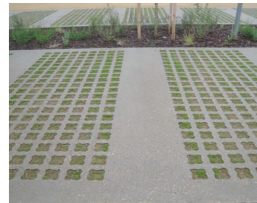
Stationnement en béton alvéolaire, favorisant l'infiltration des eaux
