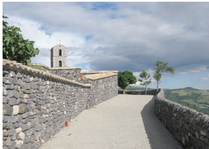
Saint-Laurent-sous-Coiron, place belvédère
