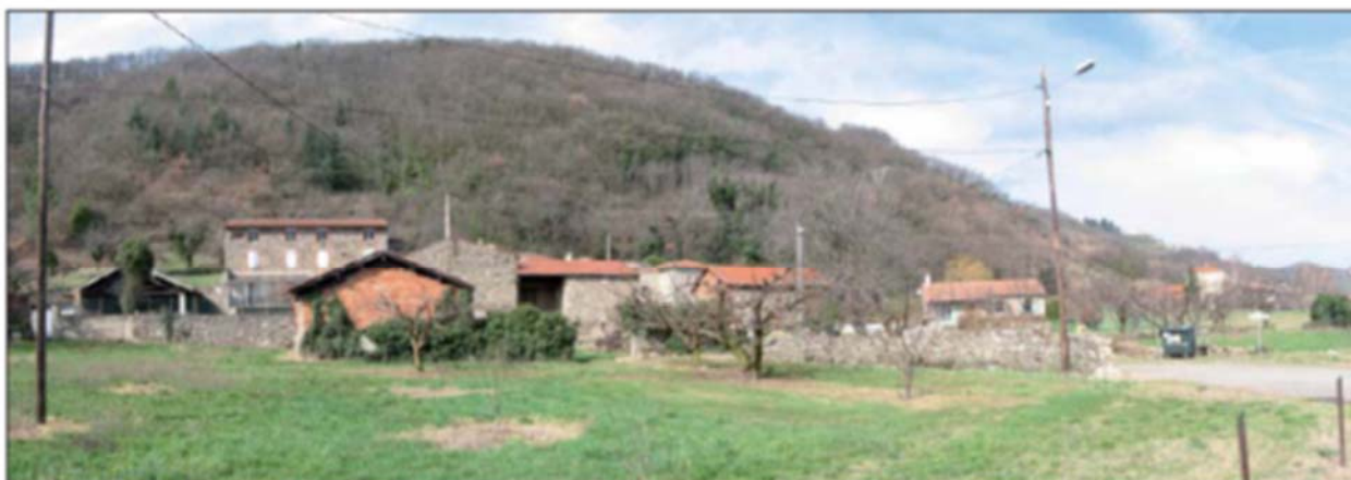
Hameau «Grand Avanon» partie sud - une ferme a probablement été à l'origine de ce regroupement
