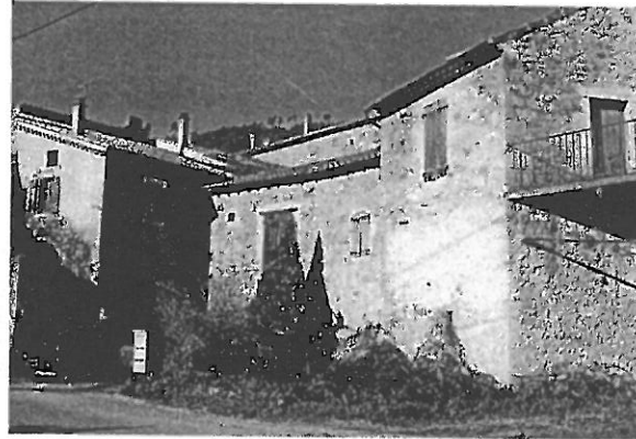
Lacour : groupement bâti traditionnel de qualité et environnement végétal (mimosa) de mise en valeur
