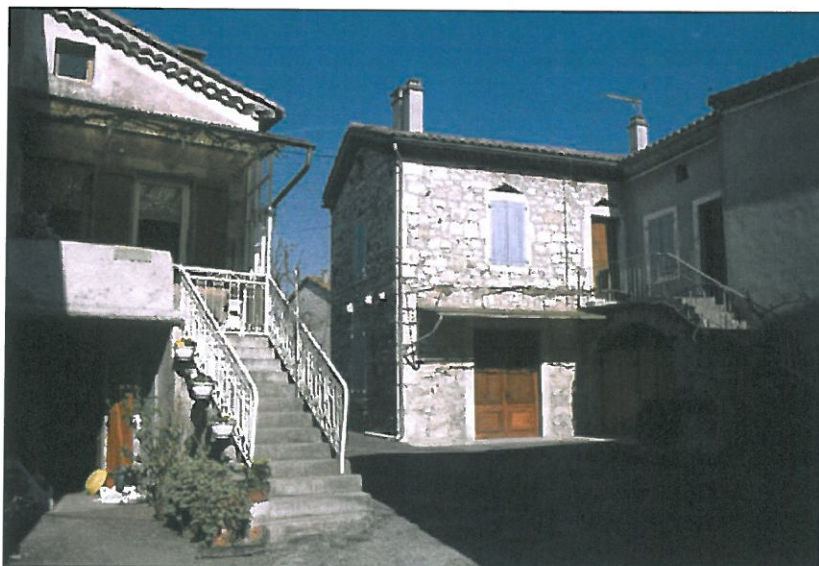
Les constructions de centre-bourg
