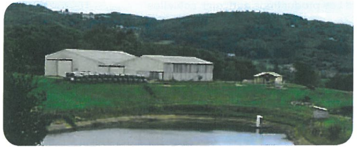
Cohabitation difficile d'un bâtiment agricole volumineux avec l'habitat.
