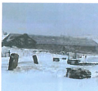
Ferme des Sucs (secteur au climat très rigoureux sous la neige). Bâtiment ramassé sur lui-même, constitué de matériaux solides et pérennes (pierre, lauze).
