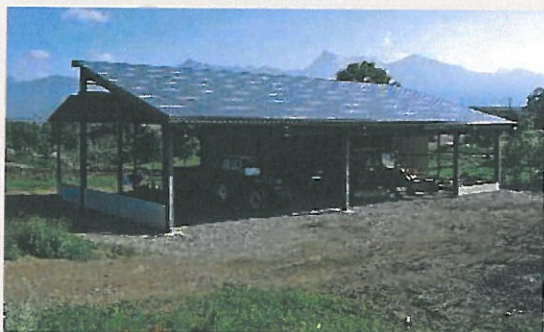
Installation sur bâtiment agricole
