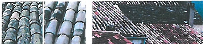
Patchwork de couvertures en bâles "canal", tuiles mécaniques et lauzes
