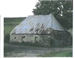
Pierre et tôle ondulée en couverture.
