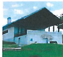
Stac, béton brut et structure méditerranéenne
