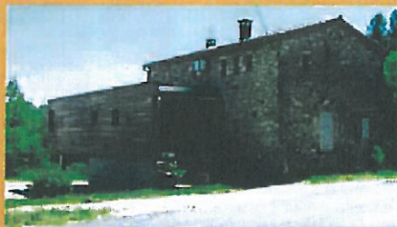
Saint-Julien-du-Serre, extension en bois
