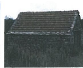
Pierre, tuile et lauze en couverture.
