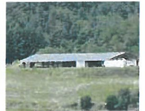
Charpente lamellé-collé et bac acier.
