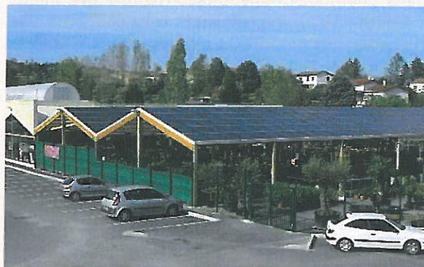
Installation sur bâtiment commercial
