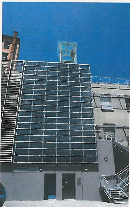
Intégration verticale de panneaux photovoltaïques
