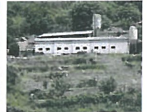
Préfabriqué béton et amiante ciment.
