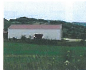
Bac acier en mur et couverture.
