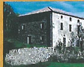
Ancienne ferme à Roddes, toiture à quatre pentes sur un volume simple.
