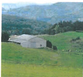
Bâtiment agricole classique, bien implanté dans un repli du terrain à l'abri du vent.
