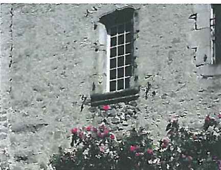
Mur de pierre avec un enduit de jointoiment.
