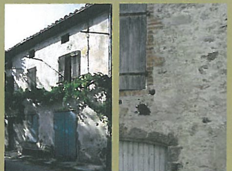
Ancien enduit à la chaux
