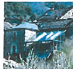
Serre et panneaux solaires
