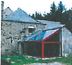
Serre en aluminium liée sur bâti ancien
