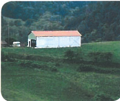
Bâtiment agricole aux teintes trop claires, visible de loin dans le paysage.
