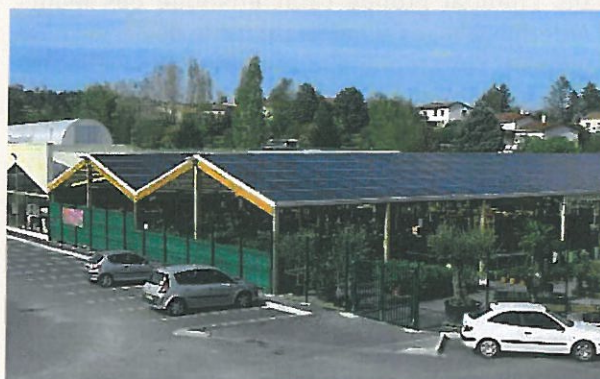
Installation sur bâtiment commercial
