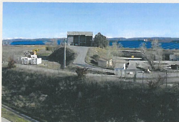
Centrale photovoltaïque au sol sur ancienne décharge
