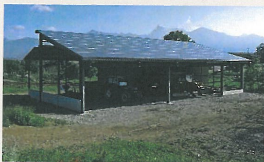
Installation sur bâtiment agricole
