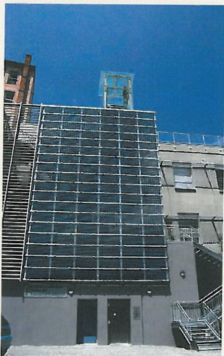
Intégration verticale de panneaux photovoltaïques
