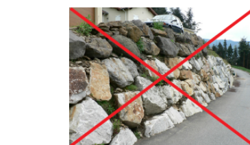
Exemple d'enrochements de type cyclopéen
