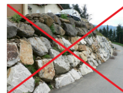
Exemple d'enrochements de type cyclopéen
