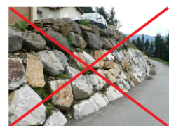
Exemple d'enrochements de type cyclopéen
