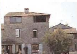
Maison contemporaine en pierre et béton pour les linteaux et encadrements. Même typologie que la maison ancienne avec combles aménagés en terrasse et loggia.
