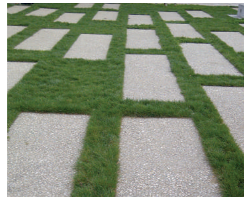
Pas japonais avec dalles de béton désactivé
