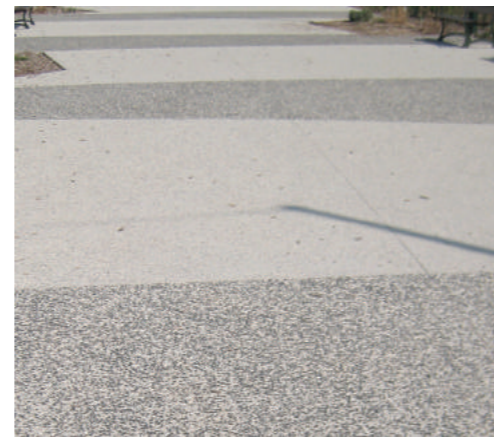
Sol avec alternance béton sablé et béton désactivé
