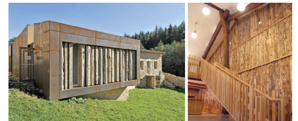
En haut : Vue avant-après / En bas à gauche : Inclusion contemporaine avec poutres de l'ancienne aétale ré-utilisées / En bas à droite : escalier et charpente
