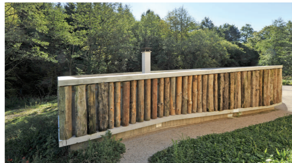
En haut : Vue d'ensemble / En bas : Chaufferie bois (recyclage de poutres)
