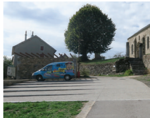
Placette traversante en béton sablé (Chalier-15)
