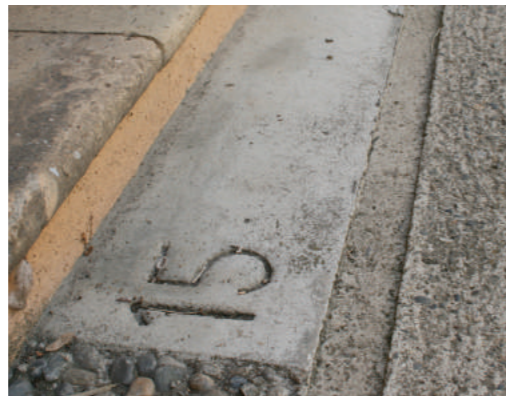
Traitement des seuils avec adresse gravée - Grisolles (82)
