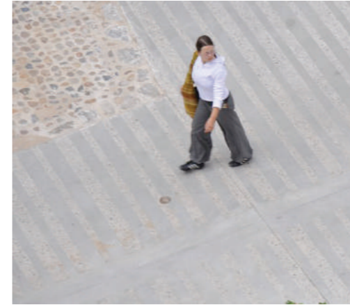
Pochoir en bande sur béton sablé
