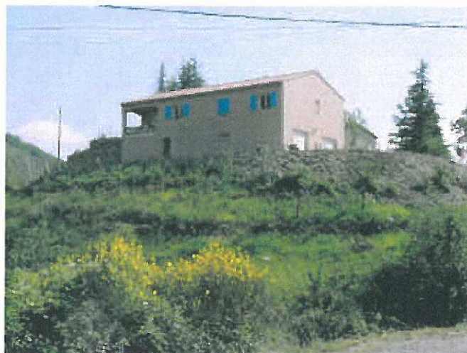
5-06 remblai sur le col
