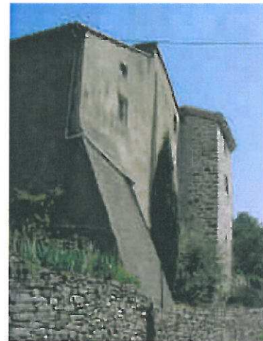
3-06 bâti dans la pente
