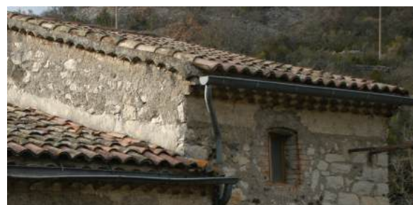
Débords de toiture avec trois rangs de génoises
