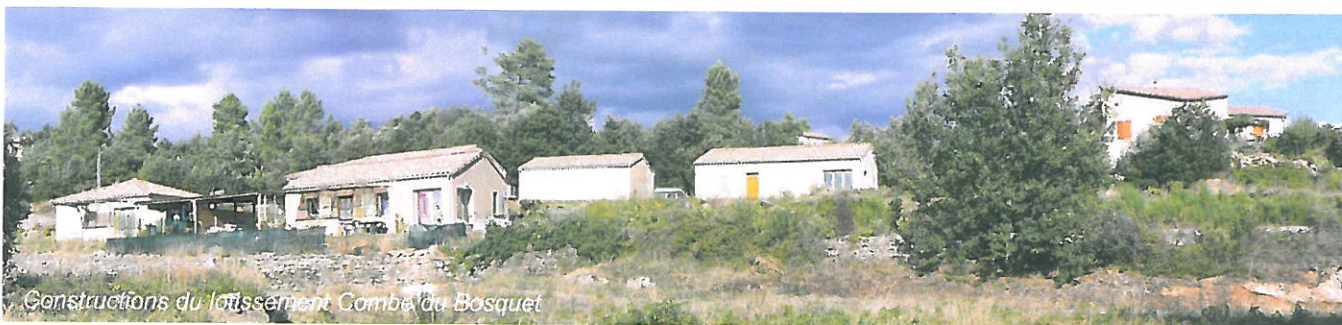
Constructions récentes au coeur du massif boisé aux Peyrières
