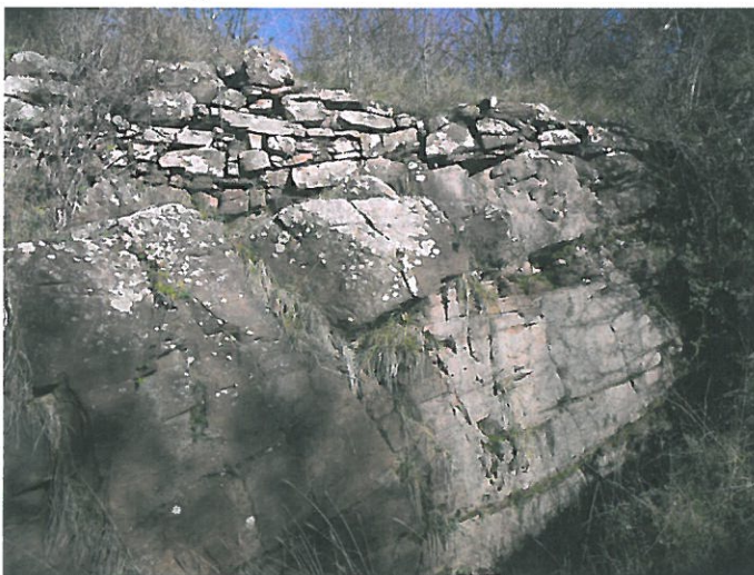
Grès affleurant et mur de soutènement de terrasse (aux environs de Coulens)
