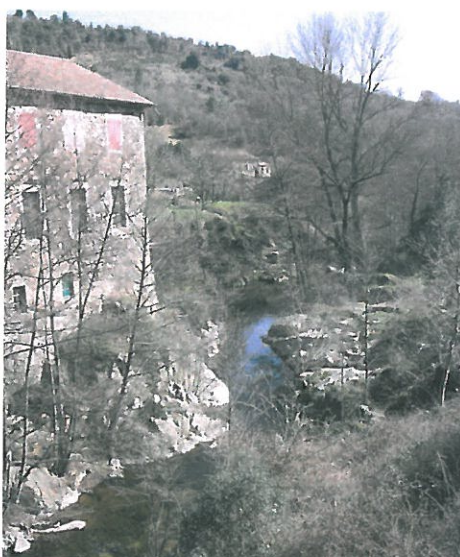
La ligne à Luthe, bâti et ripisylve
