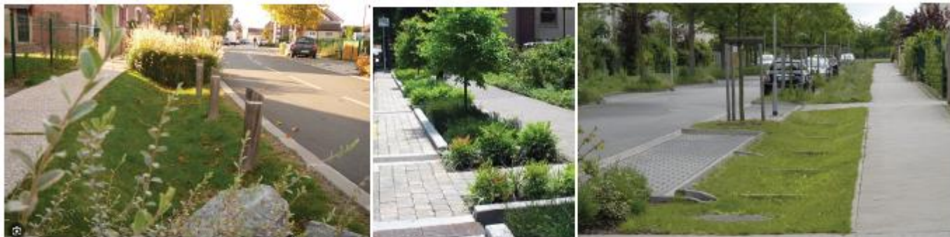
Exemples de rues-espaces public végétalisés et avec des surfaces perméables permettant l'infiltration des eaux
