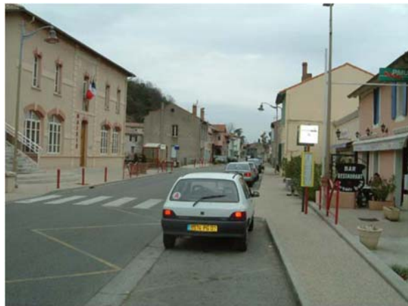
La RD86E au niveau de la mairie
