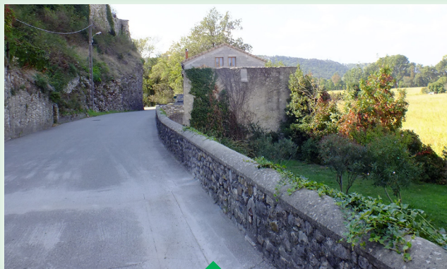
Les éléments forts de cette entrée : la vue sur le paysage de la plaine, le mur de pierre, la falaise. Les atouts pourraient être valorisés par la rénovation de la façade qui forme seuil et le traitement qualitatif des sols, par exemple avec un cheminement piéton délimité par une ligne pavée
