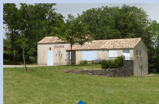
Une construction aux volumes simples, ancrée dans le terrain par un soutènement en pierre
