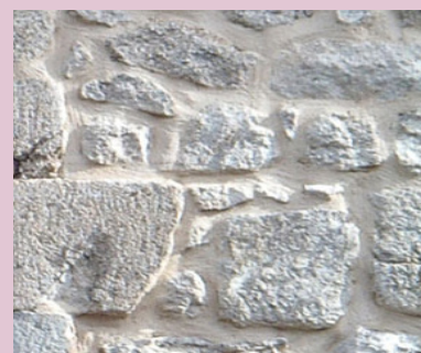
Joints à la chaux
