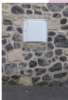
Boîtiers électriques à intégrer (si possible grâce à un volet coordonné avec les menuiseries)
