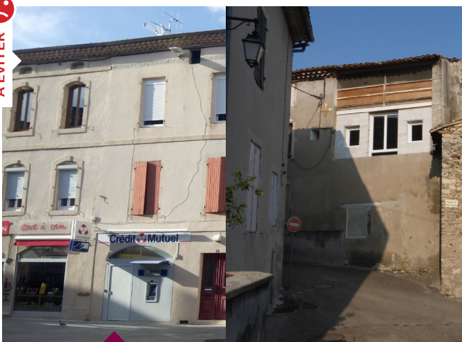
Dans cet ensemble, les interventions successives sur les menuiseries ont banalisé le caractère de la façade ( suppression des volets, volets roulants parfois avec caisson apparent, volets pliants,...).
