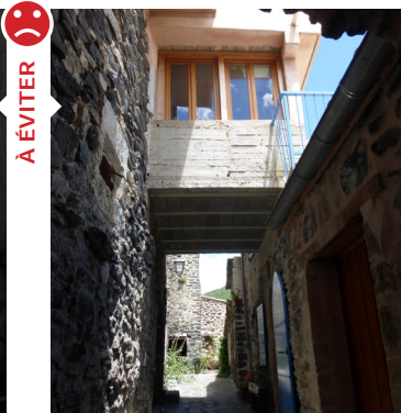
Matériaux et forme utilisés contribuent à banaliser la ruelle
