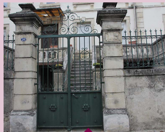
Portail, grille à barreaux verticaux en réhausse de mur
