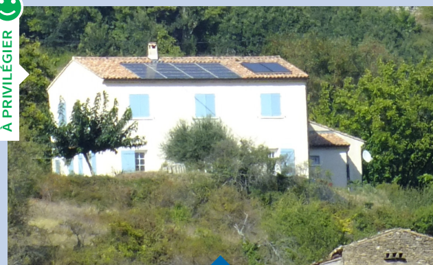
Panneaux intégrés à la pente du toit
