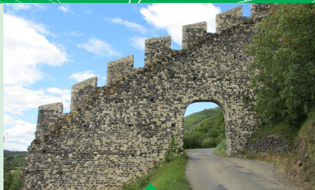
Valoriser les fortifications et les éléments du patrimoine
