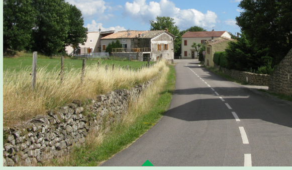
Bâti, mur de pierre sèche, bordure enherbée suffisent à créer une ambiance champêtre pour une entrée de village harmonieuse
