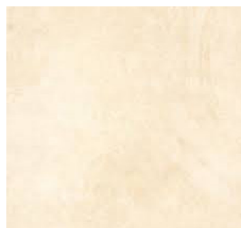
Enduit taloché avec badigeon à la chaux, deux teintes différentes
