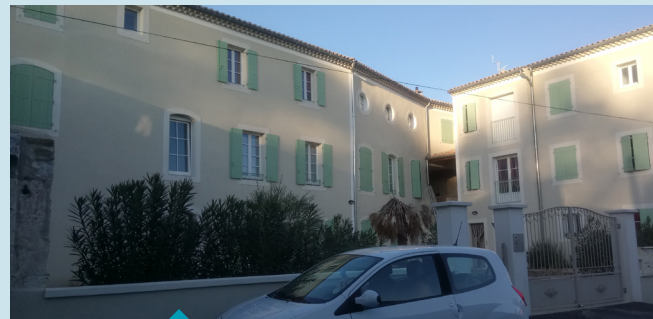
Réhabilitation et création de logements au centre de Saint-Marcel-d'Ardèche
