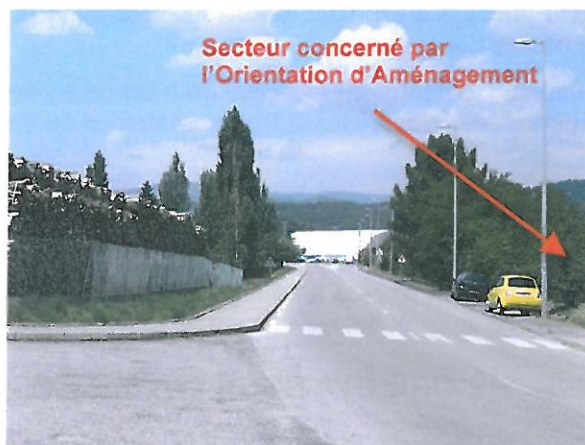
Pas d'accès privatifs sur l'Avenue de Roqua. Alignement d'arbres le long de la voie
