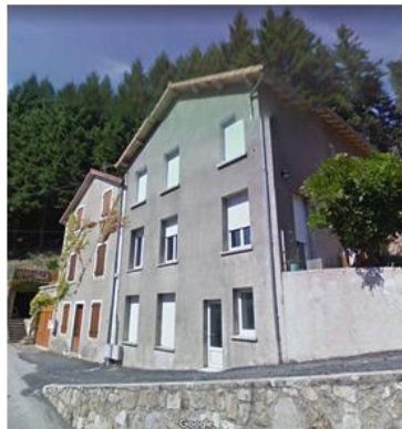
Bâti isolé le long de la RD237, source : Google maps (2009)
