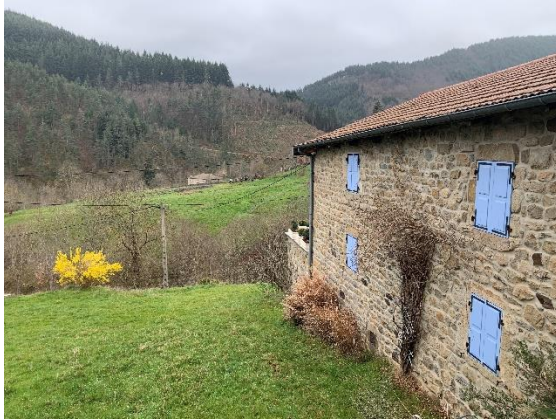
Ouverture avec linteaux en pierre, source : IATE
