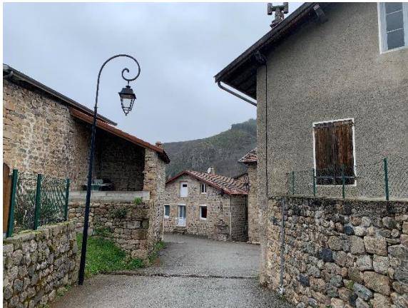
Façade du bâti traditionnel, source : IATE
