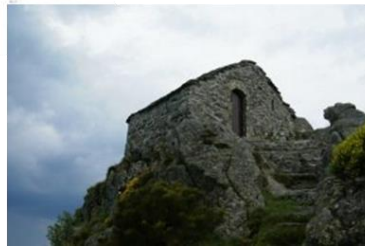
Bâti ancien, source : Arcens.fr
