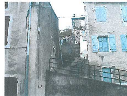
Escalier qui gravit la colline, à réaménager notamment dans le cadre de la valorisation de la colline du Greyas et de la connexion avec l'ancienne voie SNCF.
