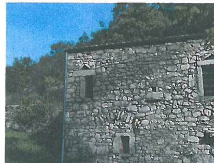
Maison traditionnelle construite sur le versant calcaire
