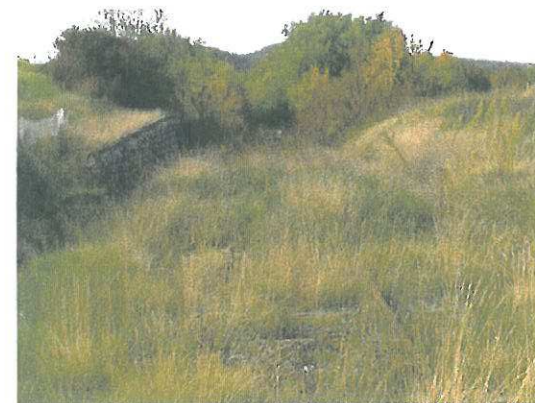
L'ancienne voie ferrée, actuellement gagnée par la végétation.
