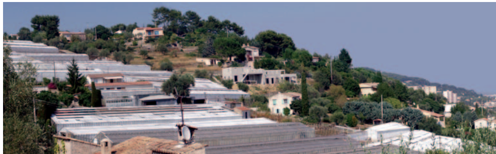
Les serres installées en escaliers sur les coteaux épousent le découpage en planches. Une adaptation de l'agriculture moderne qui reprend à son compte tout l'avantage d'une exposition au soleil maximum et une forme architecturale en cohérence avec le site. Restes d'une ancienne oliveraie antérieure aux serres. Vallon de Léouse.
