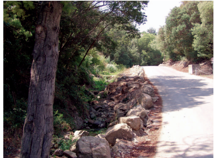
Vallon de l'Aube en aval de Super Cannes (Boulevard des Glaïeuls). Ambiance boisée préservée, mais le ruisseau n'est pas mis en valeur.
