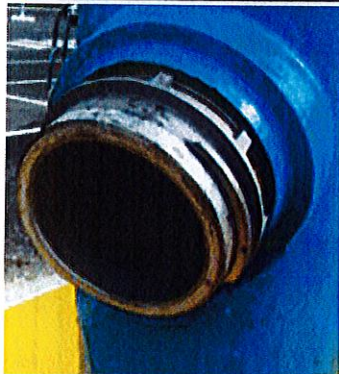
Poteau d'aspiration de 100mm, muni d'une sortie de 100mm, avec raccord fixe
