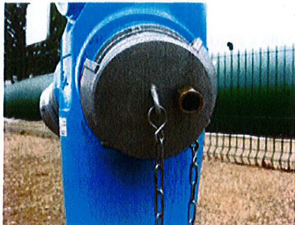
Poteau d'aspiration de 150 mm muni d'un Airclap
