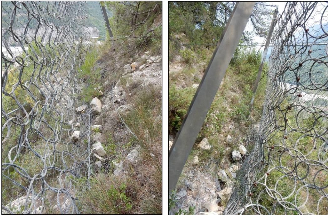
fig. 67 –Filet FE1 avant purge des pierres
