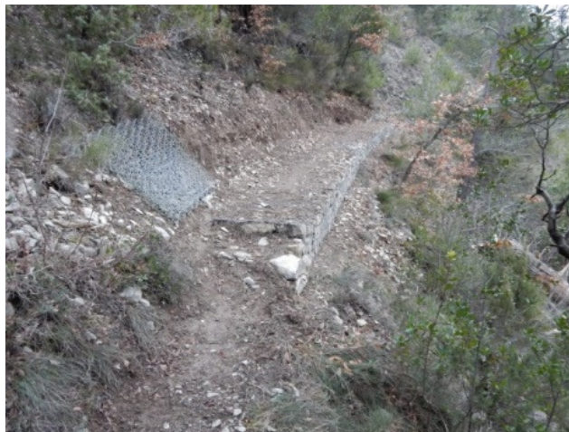
fig. 1 – Section du sentier de soutènement secteur H passant sur une semelle de gabion grillagé (travaux 2019)
