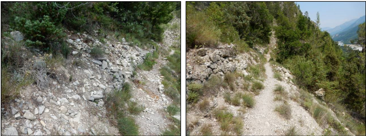
fig. 71 – Murets de soutènement secteur H avant restauration
