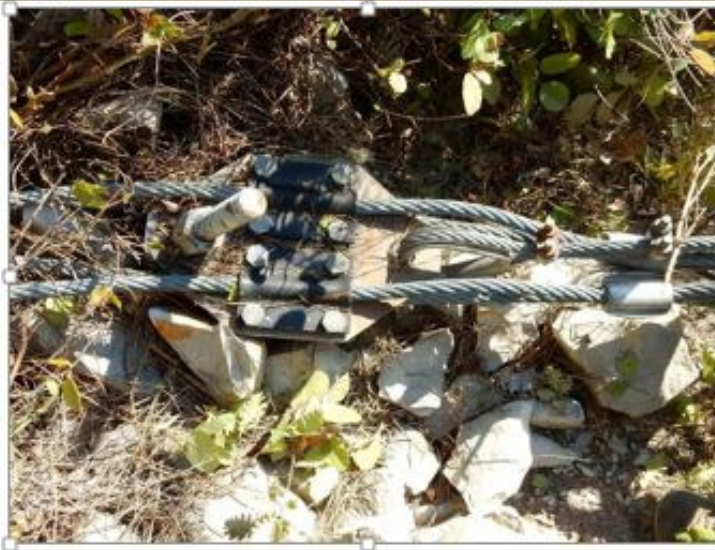
fig. 51 : Ouvrage FA1 et détail pièce frein type E.I. Montagne
