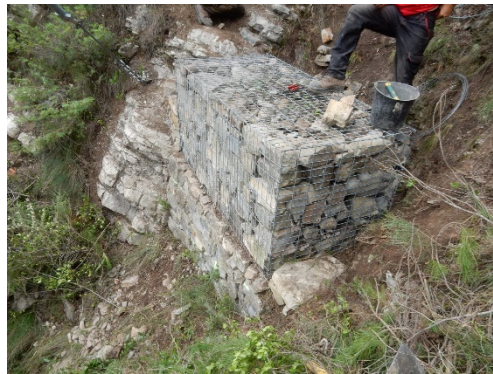
fig. 67 : Ancien seuil en pierres sèches SE3 rehaussé en gabions électrosoudés à l'aide des pierres purgées du filet FE1
