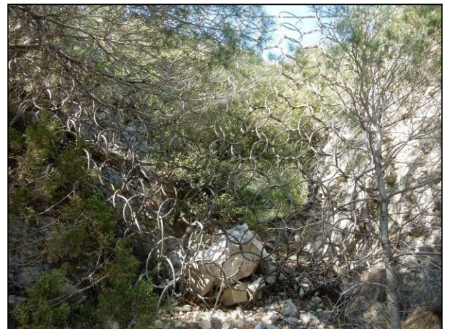
fig. 78 -Seuils en gabions SI 6 à 9 et seuil en filets à anneaux ASMI3
