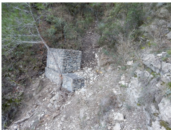
fig. 55 : Ouvrage SB6, dernier ouvrage en amont du dispositif
