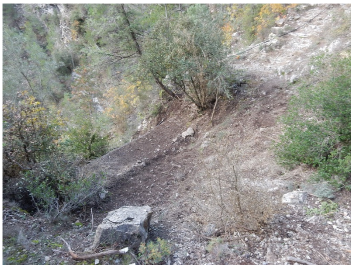
fig. 56 : Ouvrage SB6, dernier ouvrage en amont du dispositif
