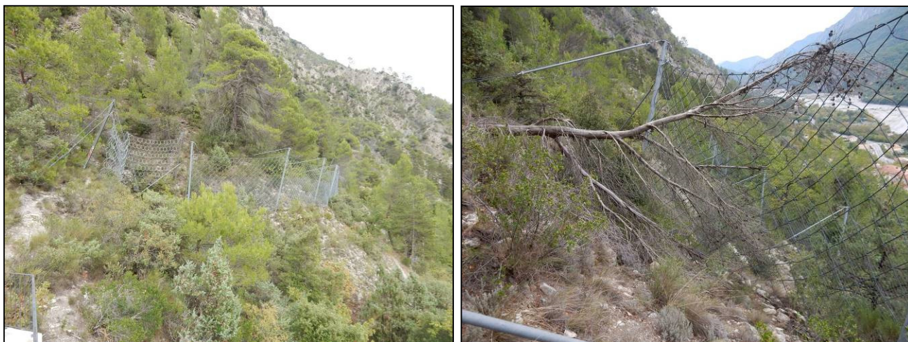
fig. 68 - Filet FE2 en amont du sentier
