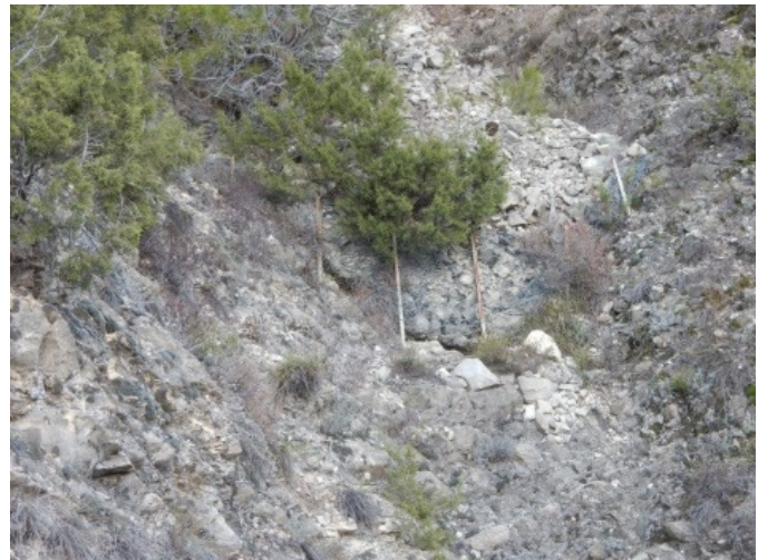
fig. 79 : Seuils grillagés (SJJ1et 2)
