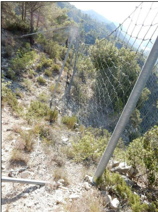
fig. 65 : filet FD2 et bloc intercepté en 2016
