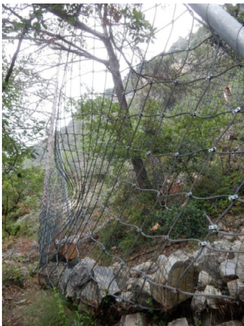
fig. 73 – Filet FH1 après la chute de l'arbre et détail de la pièce frein en rive gauche
