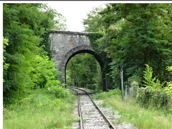
101. Ouvrage d'art sur voie ferrée, St Antoine
