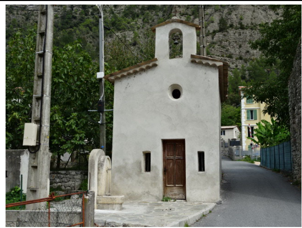
2. Chapelle, lieudit Saint Antoine, parcelle 792
