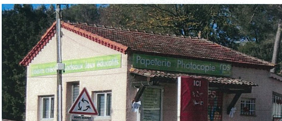
En face du pôle commercial d'Intermarché : dispositifs en bandeau. Dispositif sur pignon dont la géométrie tranche avec celle de la façade. Potentiel de valorisation.
