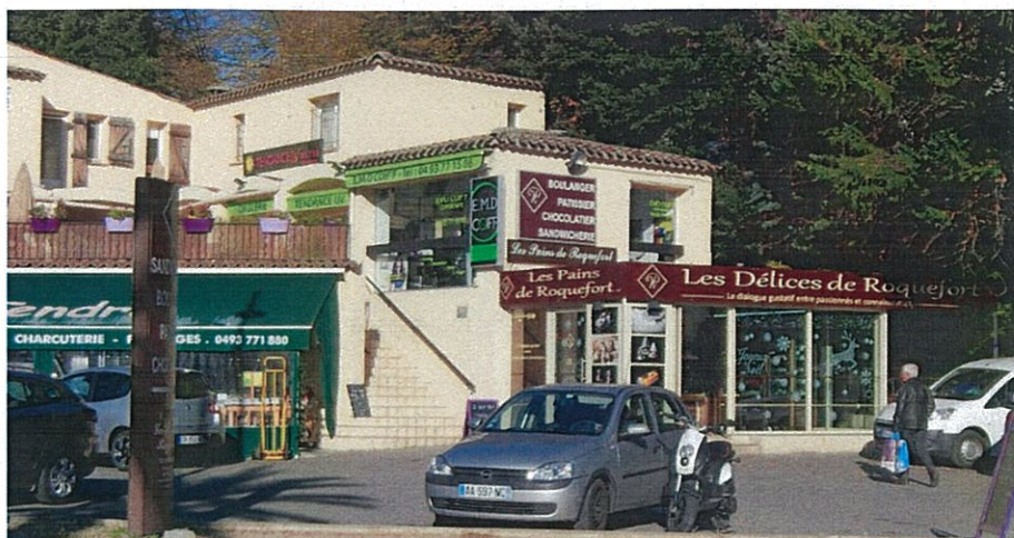
En face du pôle commercial d'Intermarché : enseignes scellées en façade essentiellement de type bandeau enseigne sur store. Densité importante de dispositifs.
