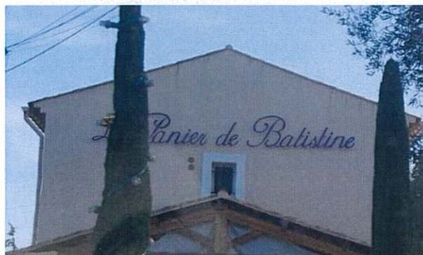
Zone du Colombier. Enseigne scellée en façade, lettres découpées apposées directement sur la façade.
