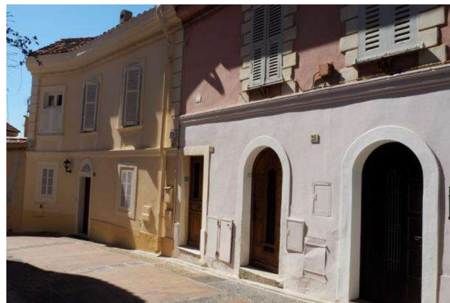
Photographie de la typologie du bâti dans le secteur du Vieux Village
