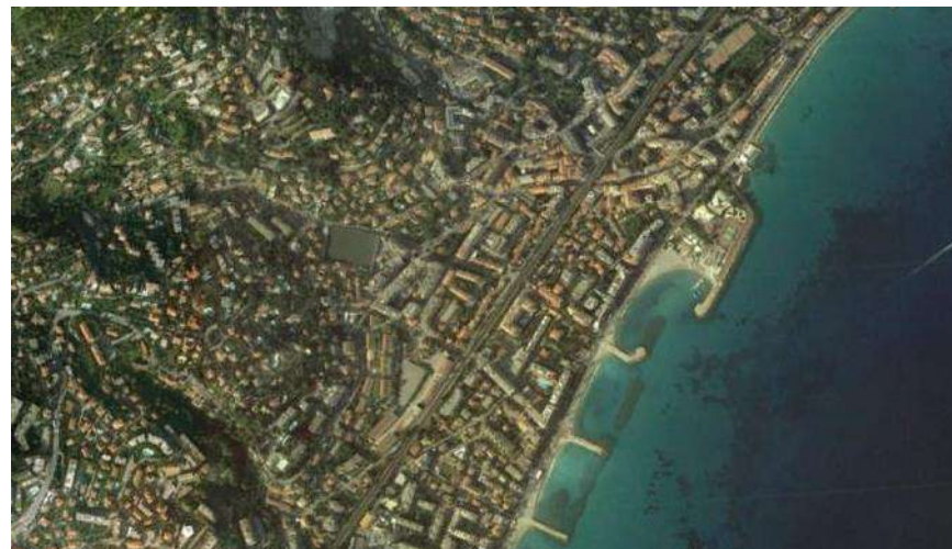
Vue aérienne du secteur de Carnolès
