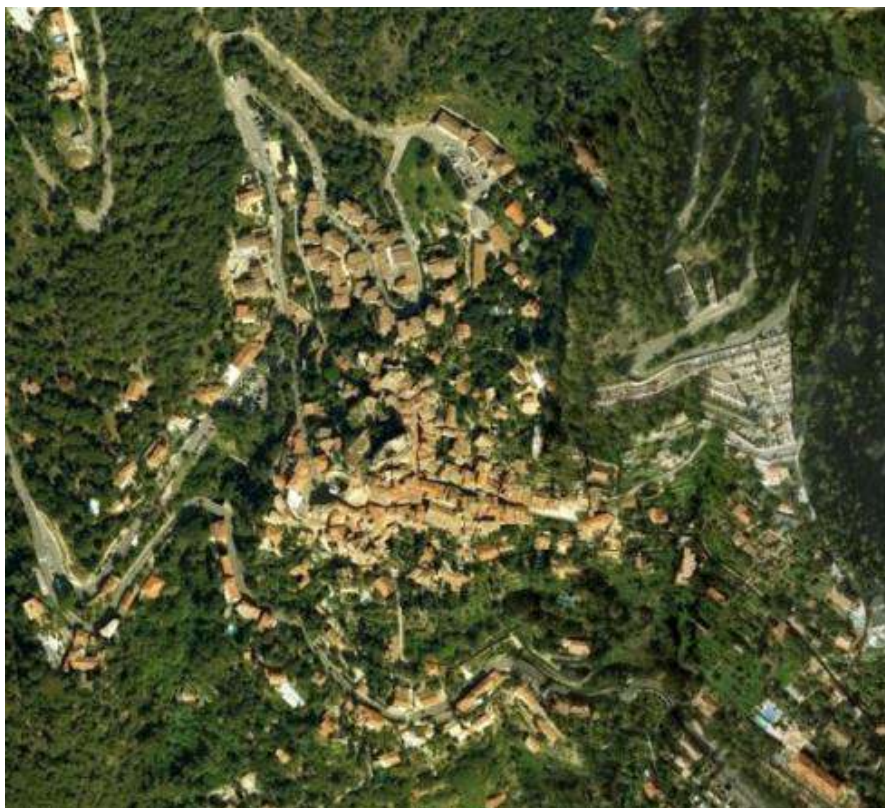
Vue aérienne du secteur du Vieux Village
