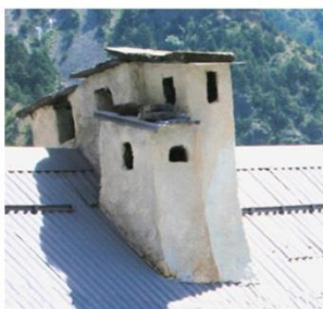
Photo et croquis de cheminées de Péone; béton lissé protégé par une dalle d'ardoise.
