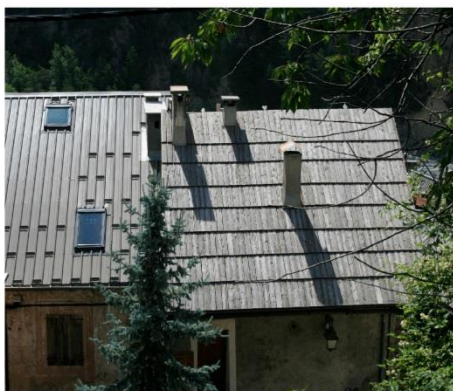
Photo prise à Péone de toiture en bac acier (à gauche ) et en bardeau de mélèze (à droite).
