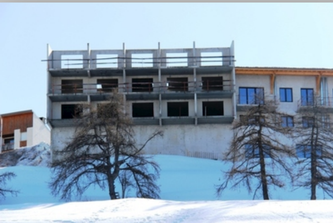
PROJET DE RÉHABILITATION EN LOGEMENTS POUR ACTIFS – LES BALCONS DE VALBERG
