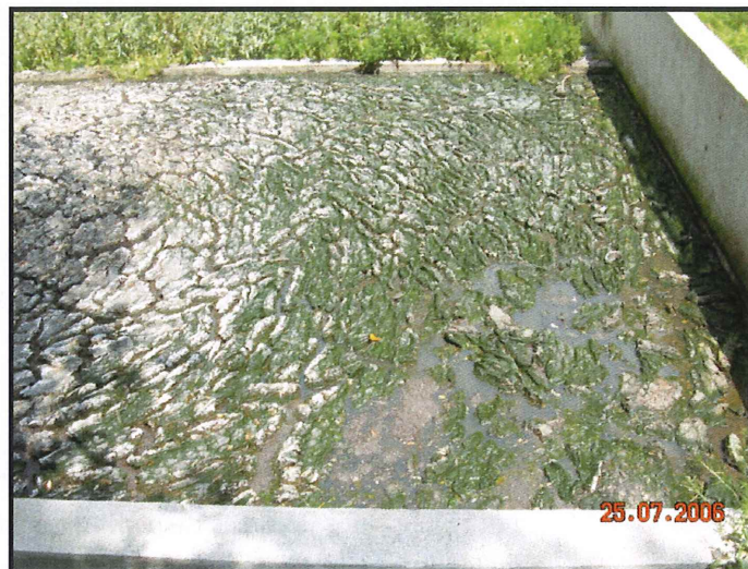
Photos 19 et 20 : Lits de séchage des boues
