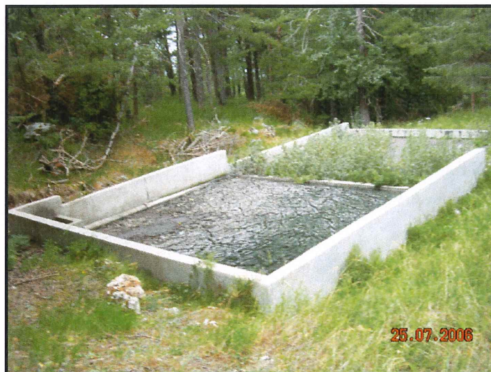
Photos 19 et 20 : Lits de séchage des boues
