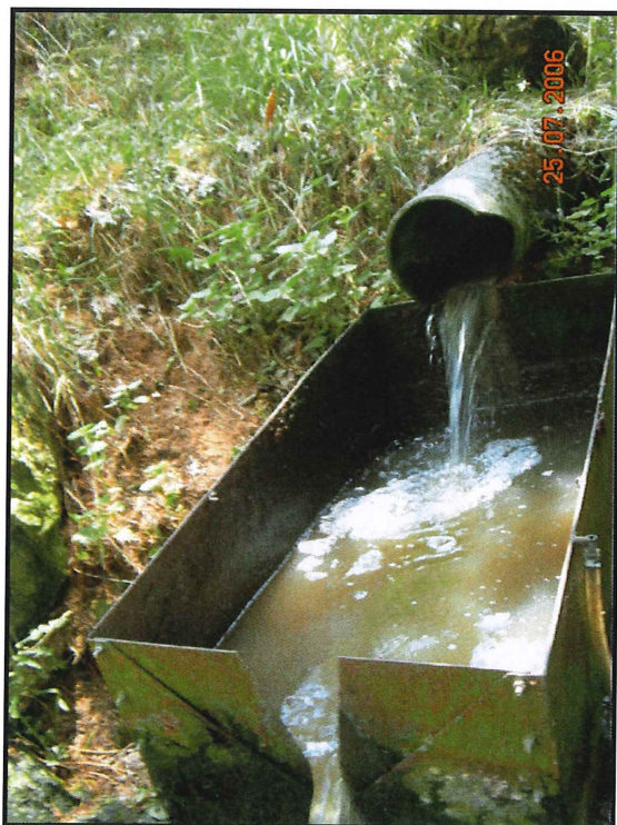
Photo 17 : Canal de sortie
