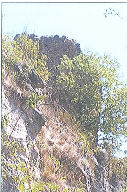
Les vestiges d'une tour du château
