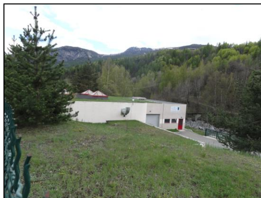
Station d'épuration de Vallouise de type lits bactérien
