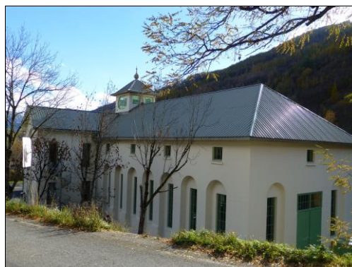
Centrale hydro-électrique de Pelvoux
