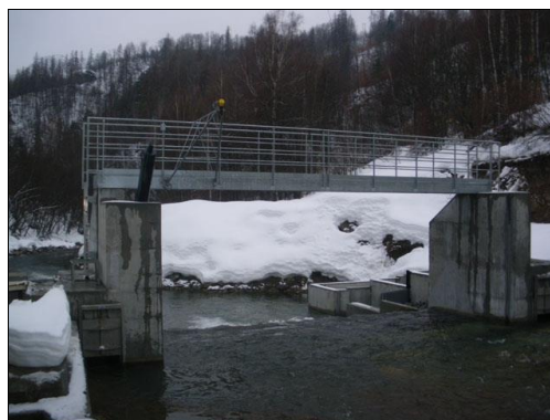
Centrale hydro-électrique de Vallouise
