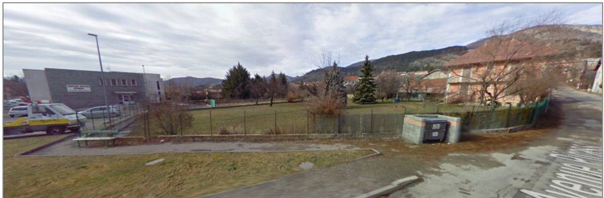
Le secteur de Rambois vu depuis l'avenue Picasso
