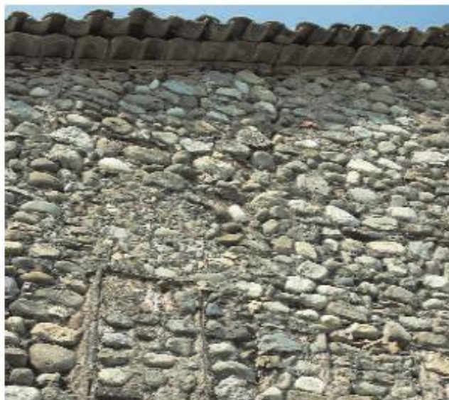
Appareillage de galets de rivière à Upaix
