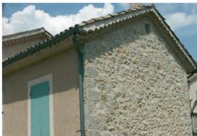
Traitements différenciés des enduits de façades (principales) et des ouvertures - (Ribeyres)
