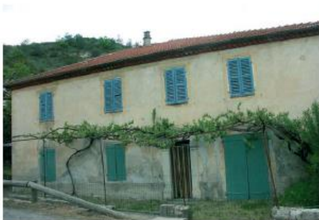
Traitements différenciés des enduits de façades (principales) et des ouvertures - (Ribeyres)
