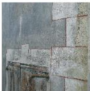
▪ enduit taloché, dressé et frotté à la taloché ou au bouclier + badigeon et décors en trompe-l'œil.
