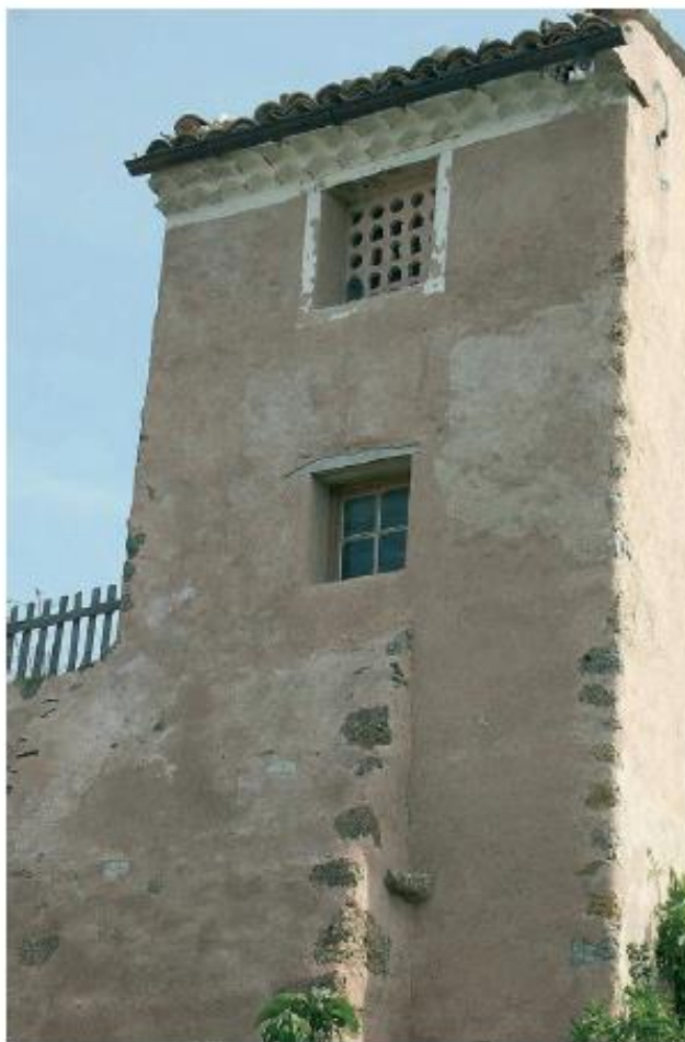
Restauration d'un pigeonier à Upaix avec ravalement de façades à l'enduit de plâtre local fabriqué à l'ancienne (2001) (Association de Valorisation du gypse et du plâtre dans les Alpes du Sud)
