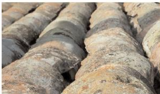
Une couverture omniprésente dans le paysage : la Tuile canal
