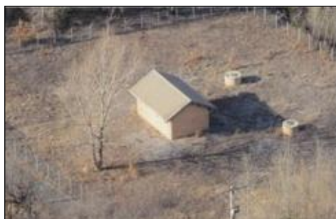
Forage de Chaussetives
