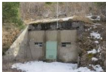
Réservoir de Gréoliers
