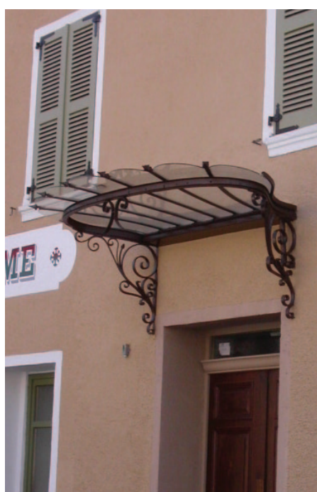
Exemple de marquise
