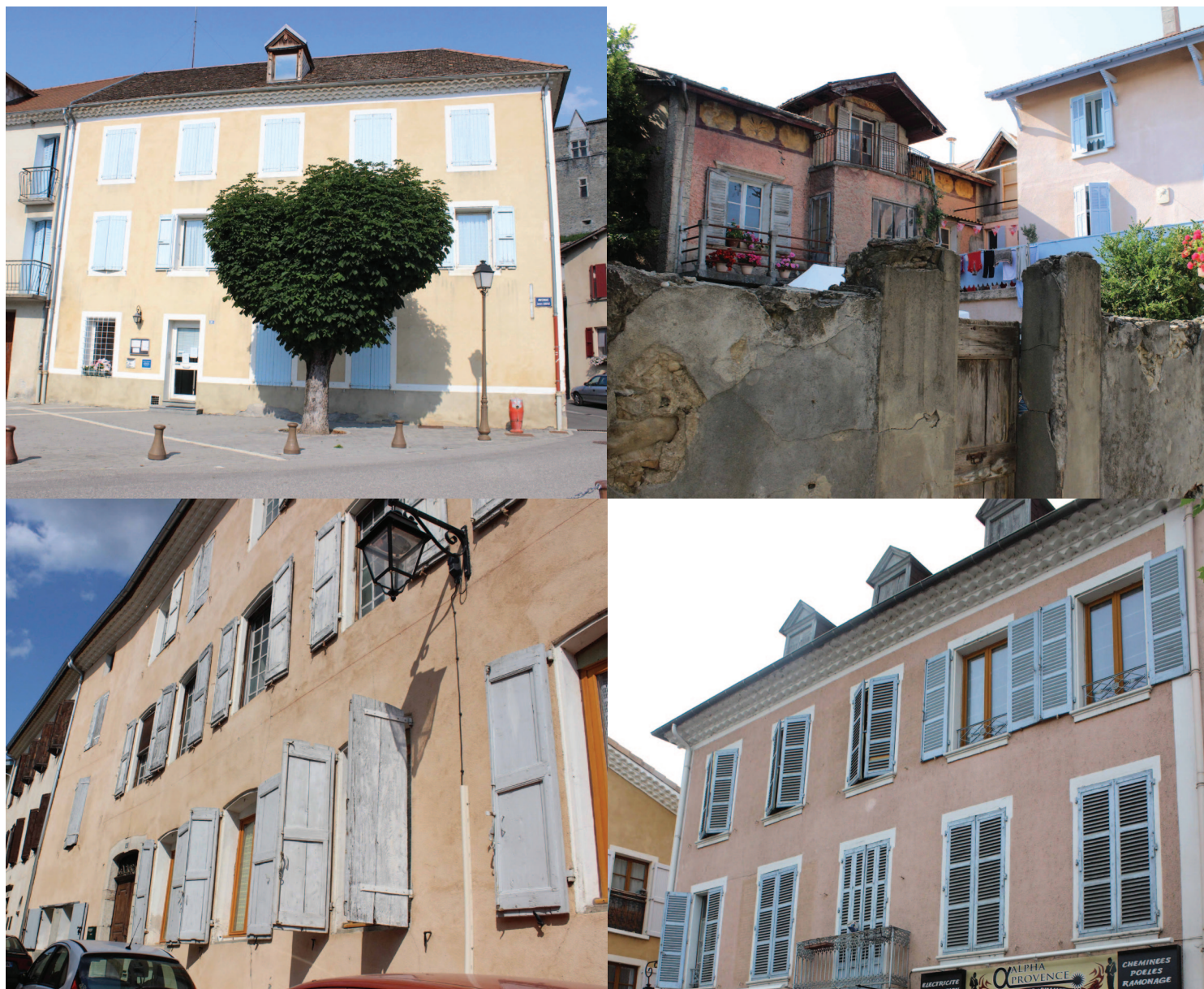
Exemples d'édifices repérés comme remarquable dans le centre ancien de Tallard
