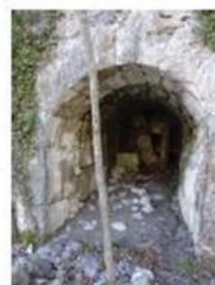
Four à Chaux Gauthier (5)
