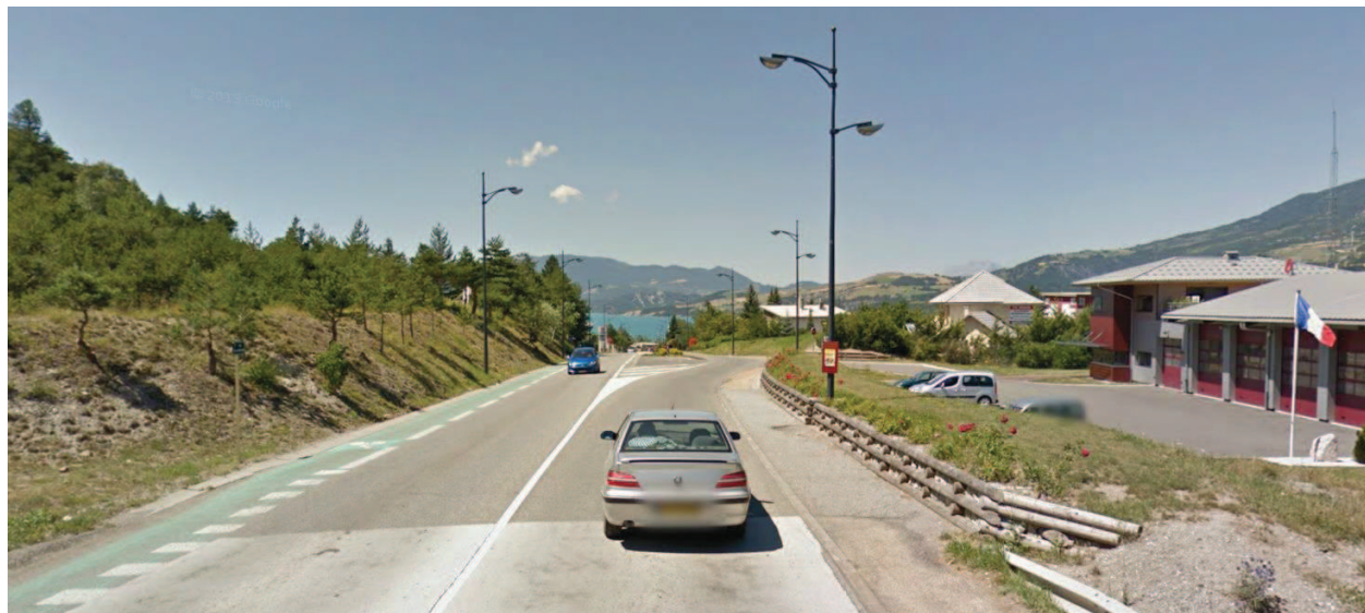
Vue sur le carrefour du centre de secours
