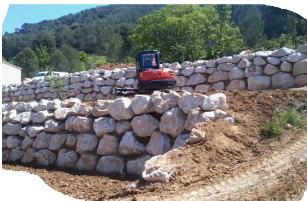
Enrochements calibrés en terrasses, permettant de limiter les hauteurs de soutènement. A droite, blocage de pied de talus en enrochement, une solution pour réaliser un aménagement à taille humaine de la pente et des abords.
