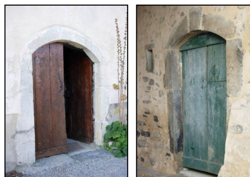
Photographie 35 et 36: Portes anciennes
