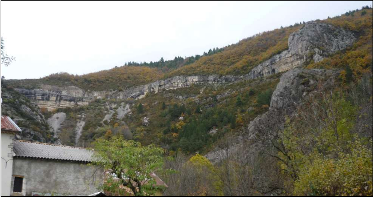
Figure 15 : Gros blocs et tabliers d'éboulis, sous un escarpement calcaire du Tithonique, au-dessus du village de la Beaume (source : IMS RN )
