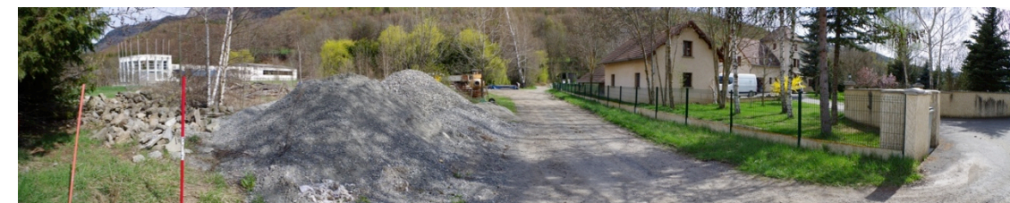
Piscine, chantier et maison d'habitation en front de RD
