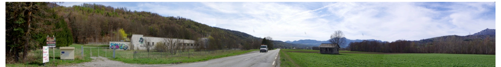
Depuis la RD 944 en venant de Pont du fossé : l'arrière des tribunes du bassin de la piscine
