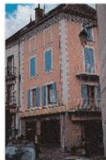
Traitement de façade en angle de rue
