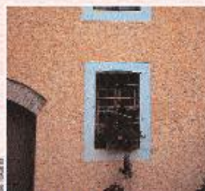
Rehabilitation de façade
